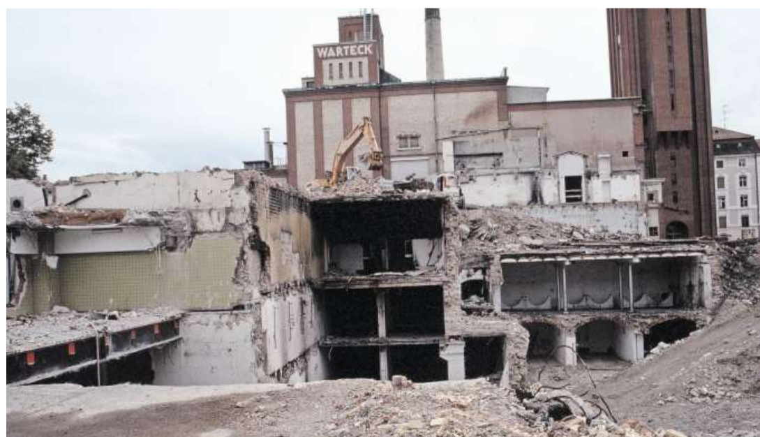
Abgerissen: Baustelle im Jahr 1992 nach Schliessung der Warteck-Brauerei. Bild: Timm Deifts
